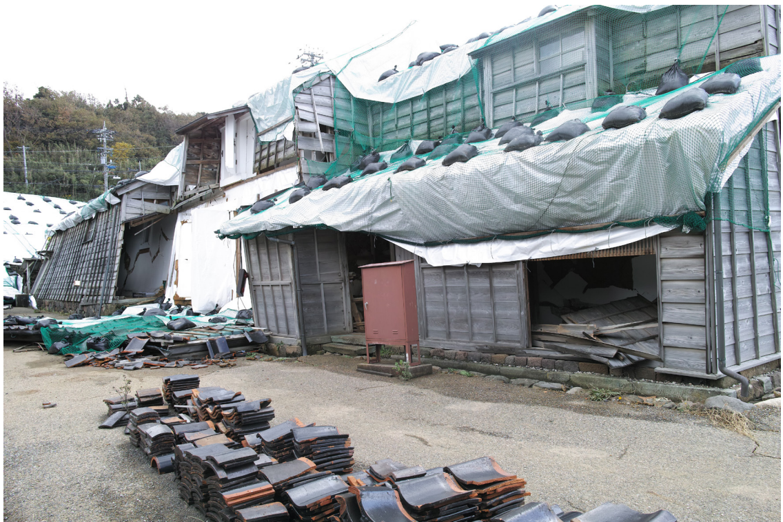
土蔵群三棟を海側より見る 屋根と、倒壊した庇部分を養生した。
