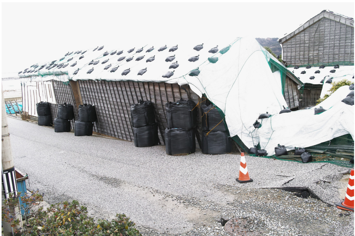
土蔵群三棟 屋根や、板壁が脱落した箇所を養生した。
