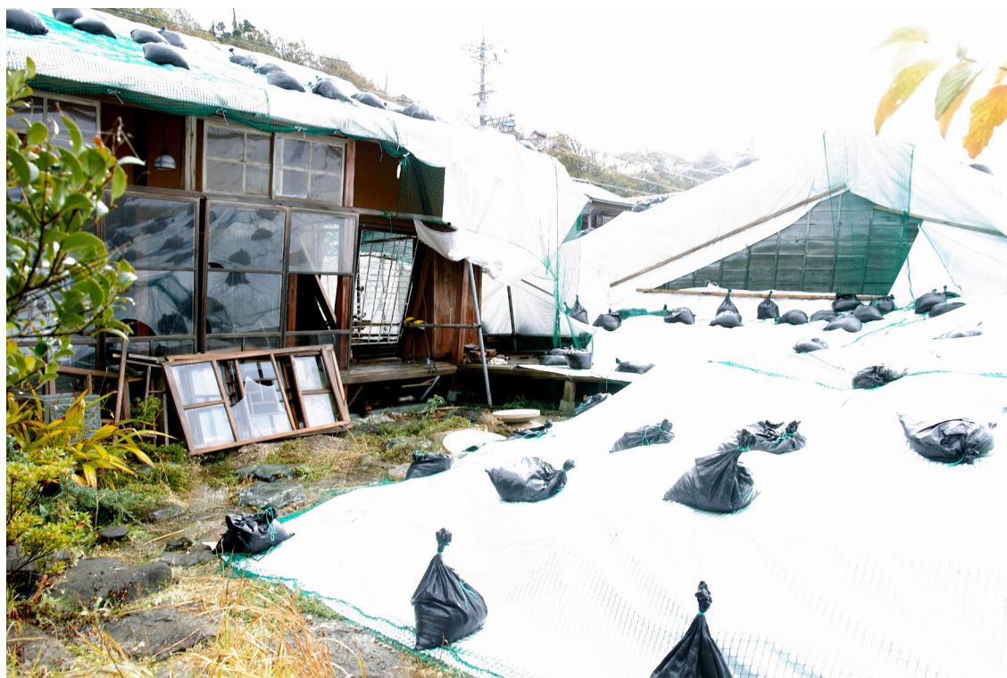
中庭（ミツボカコイ）から主屋方向を見る 倒壊した建物も、可能な限りシートで養生した。
