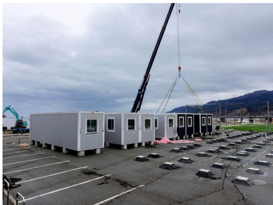
輪島市マリンタウン 応急仮設住宅マリンタウン第1団地 (キリコ会館多目的広場)建設現場
