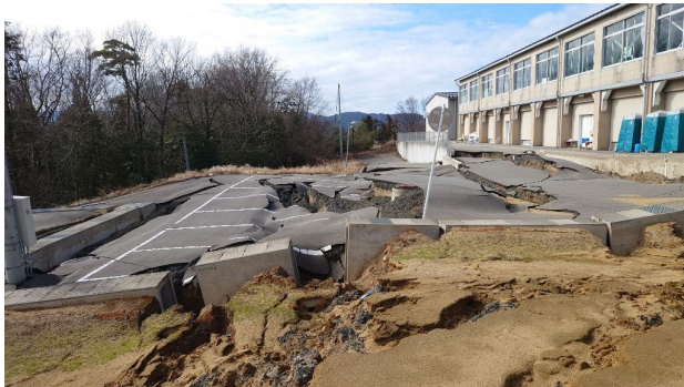
輪島中学校 避難所の様子 88
