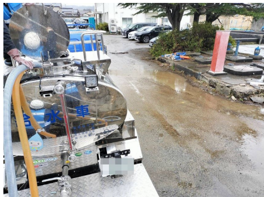
輪島浄水場 給水車への注水の様子 3
